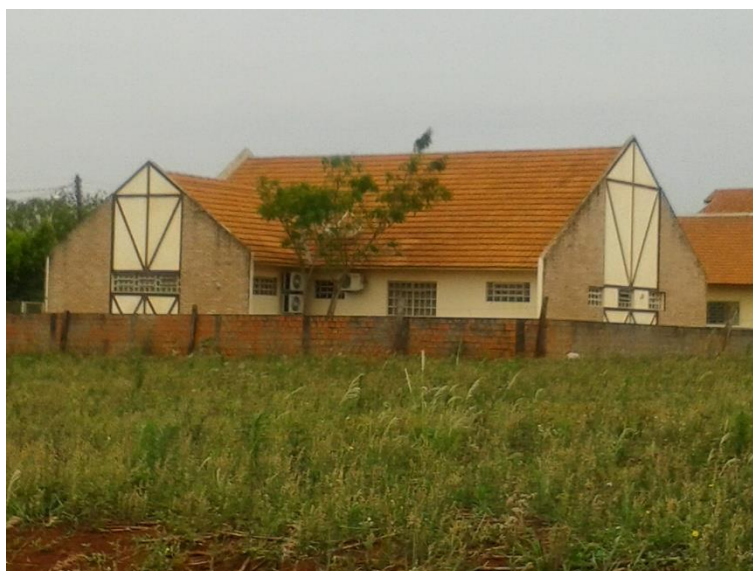
IMAGEM 1.2 – MUNICÍPIO DE MARECHAL CÂNDIDO RONDON – PADRÃO DAS INSTALAÇÕES DAS UBS. NESTE CASO, UBS SÃO LUCAS
