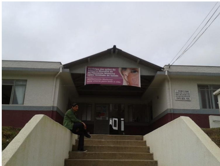
IMAGEM 1 – MUNICÍPIO DE PIRAQUARA - PRECARIEDADE DAS CONDIÇÕES DE ACESSO PARA PESSOAS COM NECESSIDADES ESPECIAIS NA UBS CENTRAL OSMAR PAMPLONA
