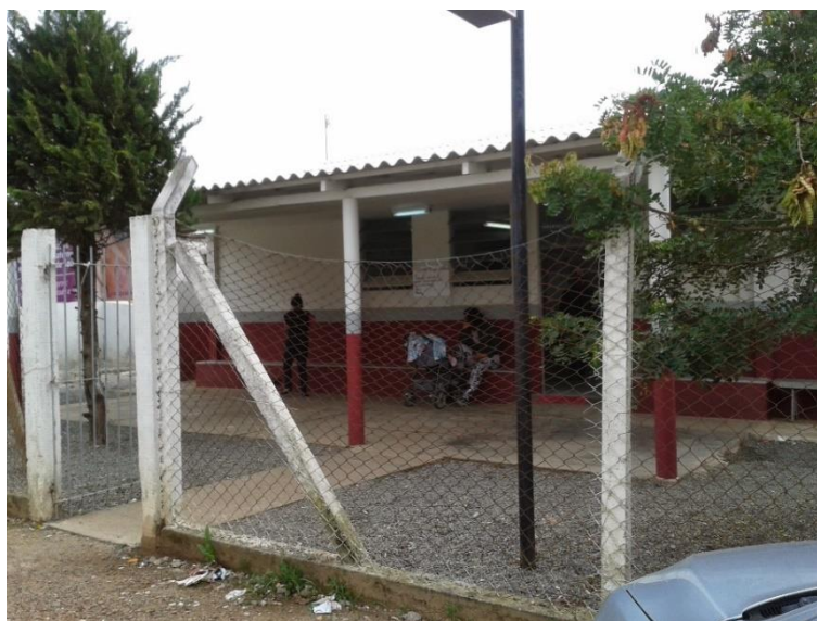
IMAGEM 2 – MUNICÍPIO DE PIRAQUARA - MELHORES CONDIÇÕES DE ACESSO PARA PESSOAS COM NECESSIDADES ESPECIAIS NA UBS PRIMAVERA DR. FLAVIO CINI
