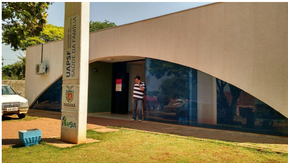
IMAGEM 5 – MUNICÍPIO DE SANTA CECÍLIA DO PAVÃO - FACHADA DA UAPSF DO MUNICÍPIO, A QUAL DISPÕE DE CLIMATIZAÇÃO ADEQUADA SOMENTE NA SALA DO GESTOR E DE BANHEIRO COM PAREDE DE VIDRO
